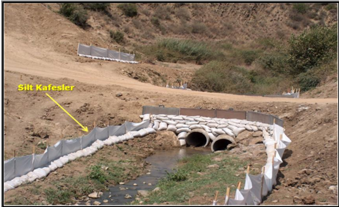
Şekil V.1.19.6. Sedimentasyon Kontrolünde Silt Kafes Uygulaması
