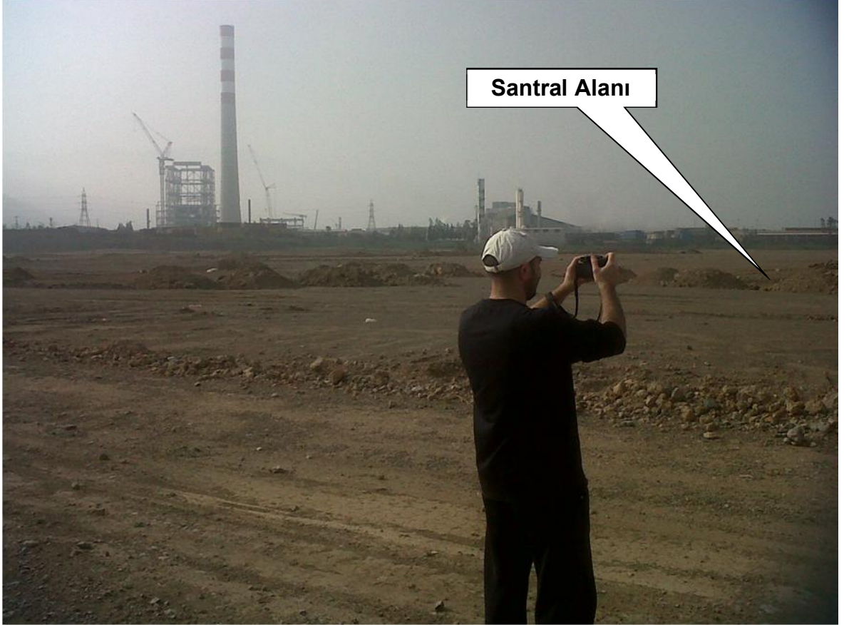
Şekil IV.2.17.1. Santral Alanı ile Sınır olan İnşa Halindeki DİTES'ten Genel Görünüm
