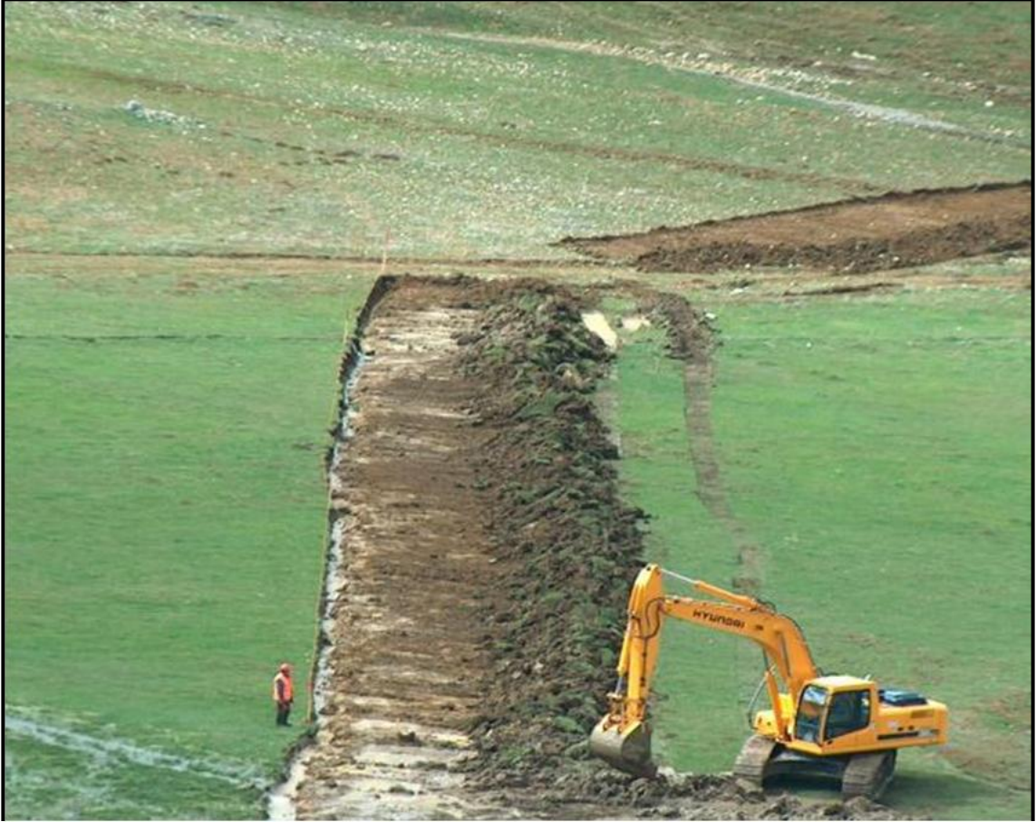
Şekil V.1.19.1. İnşaat Döneminde Bitkisel (üst) Toprağın Sıyırılması Çalışmaları
