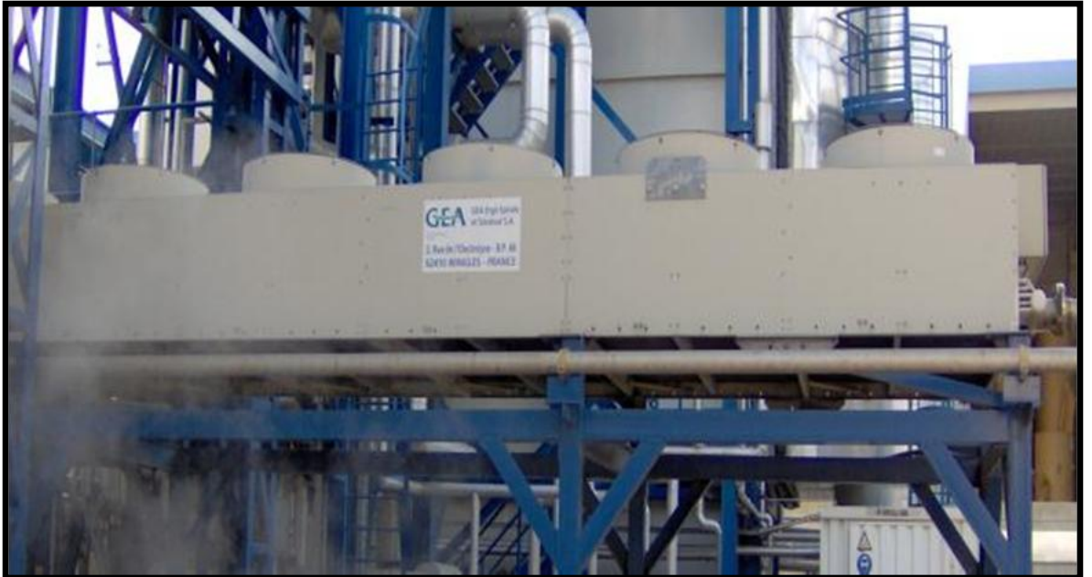
Şekil V.2.1.5. Proje Kapsamındaki Soğutma Sistemlerinin Kapalı Devresinin Fin-Fan Soğutucusunun Tipik Bir Görünümü
